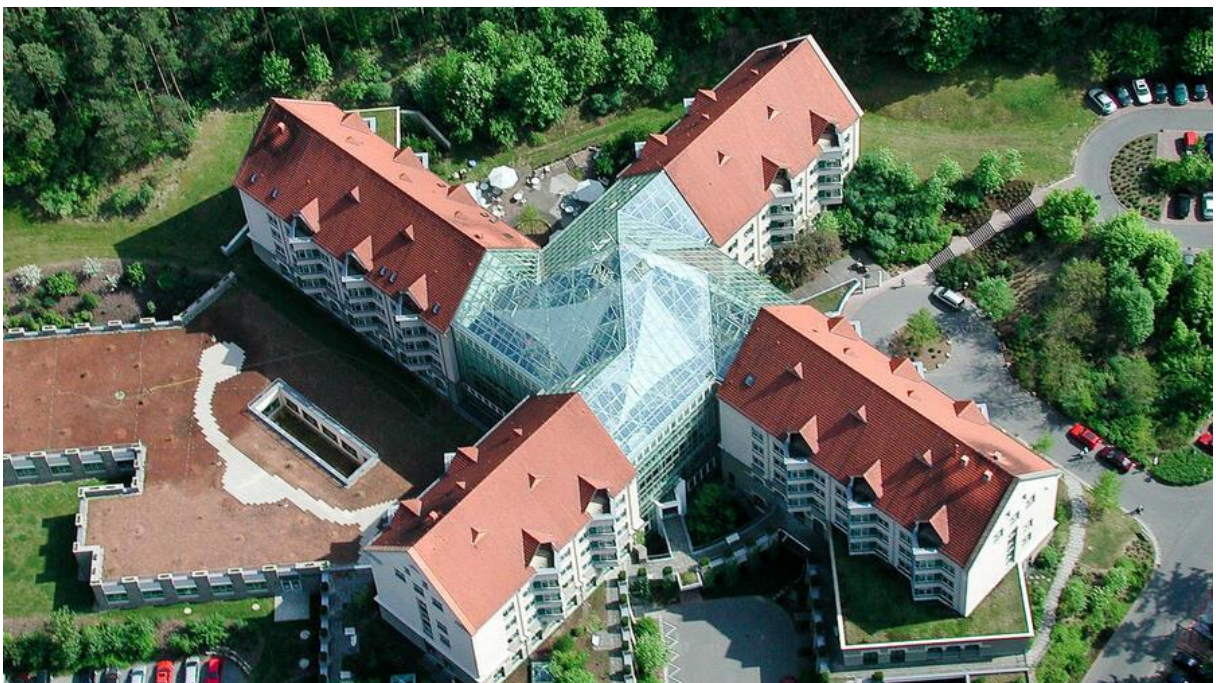
Abbildung 42: Luftaufnahme RHÖN-KLINIKUM Campus Bad Neustadt, Haus 8, Quelle: RHÖN-KLINIKUM Campus Bad Neustadt
