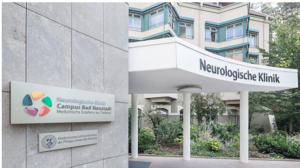
Abbildung 43: Eingang Haus 8 Campus Bad Neustadt, Quelle: RHÖN-KLINIKUM Campus Bad Neustadt
