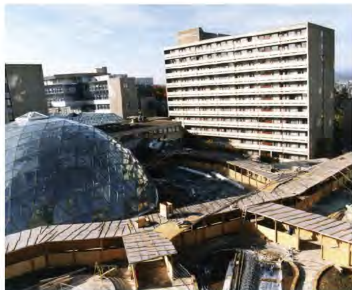
GROSSBAUSTELLE AUF DEM KLINIKGELÄNDE. Im Frühjahr 1999 wird das Zeldach errichtet. In die Klinik kamen Patienten und Mitarbeiter durch diese Tunnel aus Holz.
